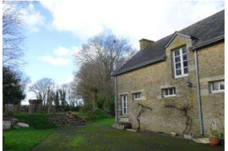
partie de la longère en cours de restauration
